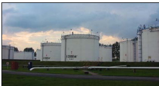
Rys.1 Baza paliw – Zbiorniki paliwowe
