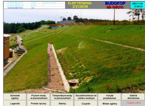
Rys.2 Górotwór objęty systemem monitorowania w Zespole Elektrowni Wodnych Dychów.
