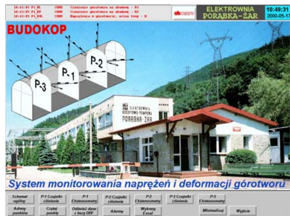
Rys.1 Ekran systemu monitorowania naprężeń i deformacji górotworu w Elektrowni Wodnej Porąbka-Żar
