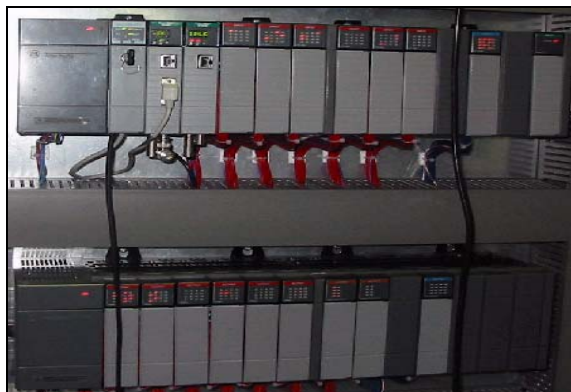
Rys.4 Wtapiarka Anod – Konfiguracja PLC (Allen-Bradley SLC 500)
